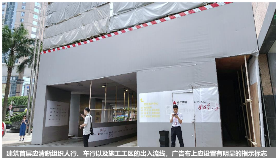
人行通道应安装必要的功能照明，外露的脚手架钢管可采用空调管胶带进行缠绕包扎处理，美观实用
